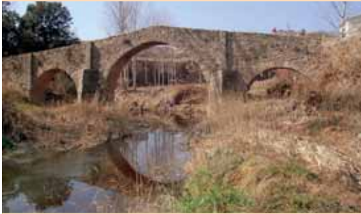
The Avinyó bridge.
